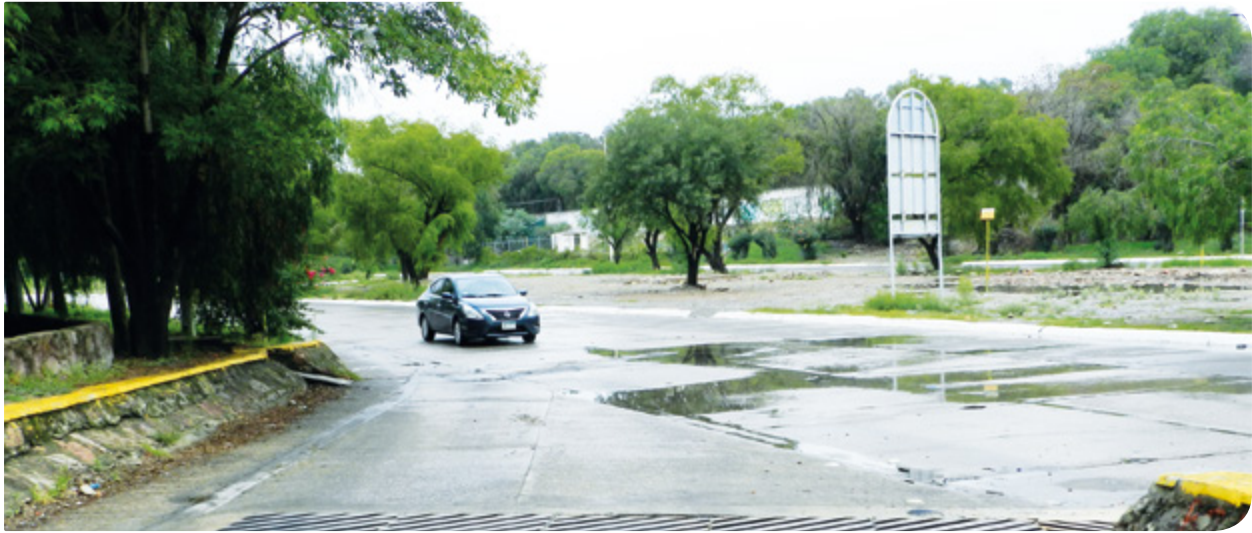
Dren central en el río Santiago .
