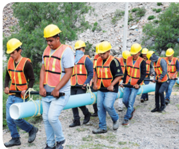
Ampliación de sistema de agua potable en Escalerillas, S.L.P.
