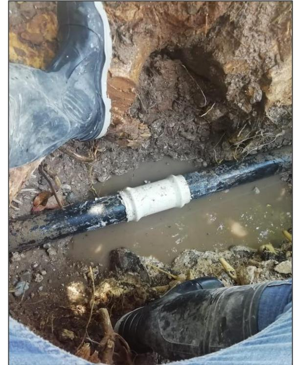
Se hizo la reparación de una fuga en Circuito Tequisquiapam #132, la cual estaba en la red de distribución y fue ocasionada por las raíces de los árboles plantados en el camellón. Se tuvo que cortar las raíces que estaban dañando el tubo y se le informó al usuario que sería conveniente que sacara por completo el árbol ya que podría seguir dañando la red de distribución de agua
