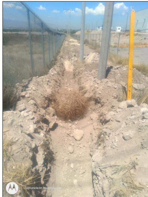
Se ejecutó la instalación de una línea de agua potable de 2" para alimentar la PTAR CS2, tanto los tanques de químicos como las instalaciones sanitarias.
