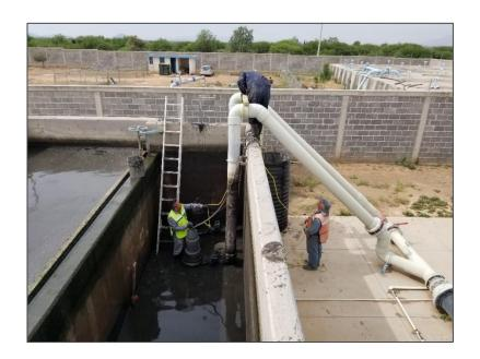
Se hizo la limpieza de los lodos que se sedimentan en el cárcamo de bombeo de los reactores biológicos de la PTAR CS1 para procurar el buen funcionamiento de las bombas de lodos.
