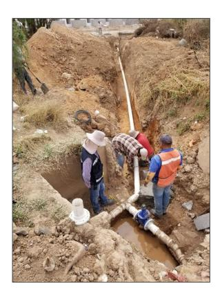
Se hizo el sondeo de la tubería de la zona baja para descubrir el punto de conexión y alimentación de la MM9, para habilitarles la toma de agua potable al desarrollo construido por grupo promotor M3G.
